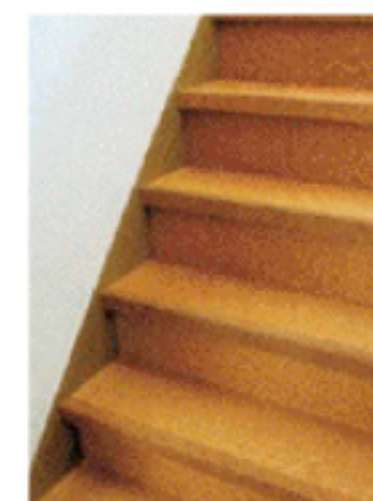
③ コルクリニューアル階段 古くなった階段に重ね貼り 滑りにくく安心
